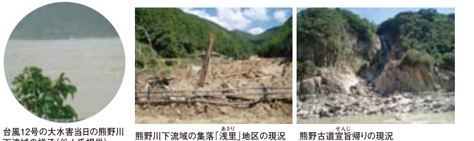
台風12号の大水害当日の熊野川下流域の様子(谷上氏提供) 熊野川下流域の集落「浅里」地区の現状 熊野古道宣言博りの現状
