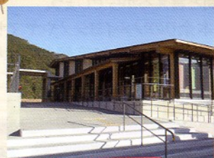
熊野本宮館 南館
